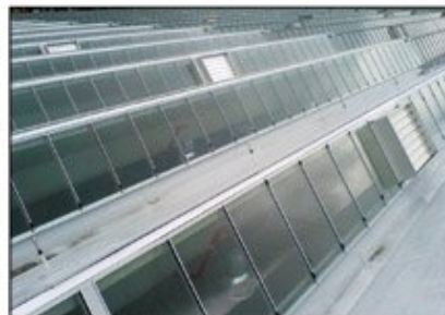
Sheddach mit PVC- bzw. Bitumenbahnen
